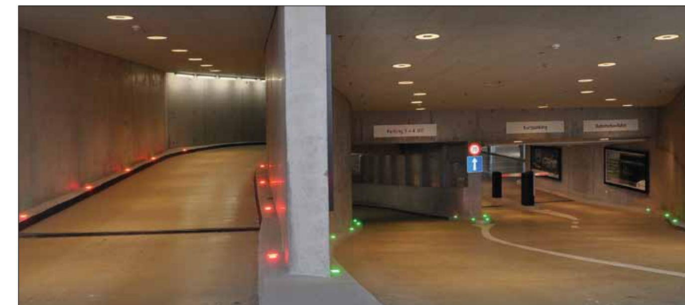
Tydlig vägledning underlättar för trafikanter.
